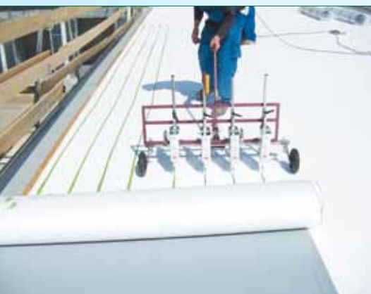
Aufbringung des Dachbahnenklebers.
