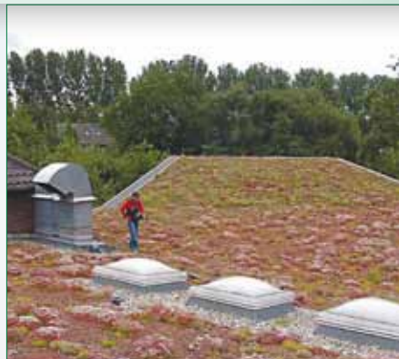
Begrüntes Dachsystem mit AUSTRPLAN FPO Dachbahn.
