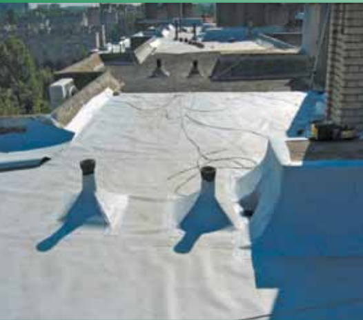
Verklebtes Dachsystem mit AUSTROPLAN F G+V.
