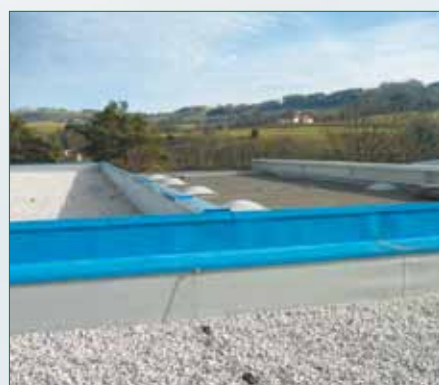
Saniertes Firmengebäude mit AUSTROPLAN FPO Dachbahn abgedichtet.
