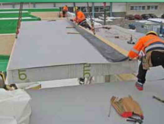
Verlegung von Fertigdachelementen.
